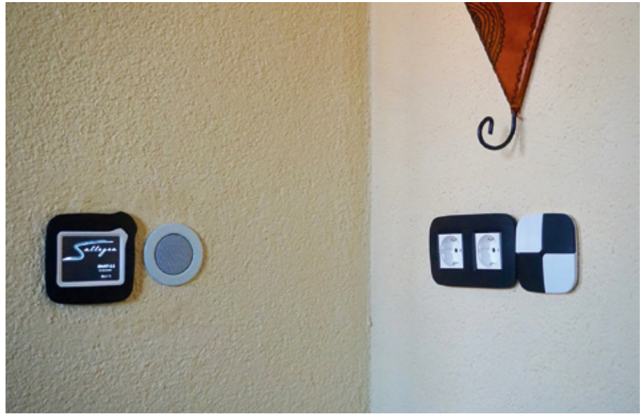
Details im Schlafzimmer: Touch-Panel „KNX eelecta“, Soundbox und „KNX Homepad“.
